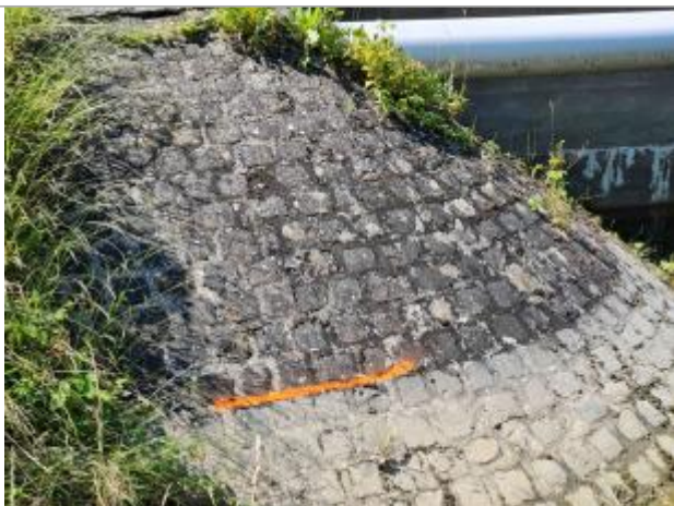
Marque peinte, à 14 pavés en partant du haut, au milieu du joint entre 14 et 15 ème pavé.
