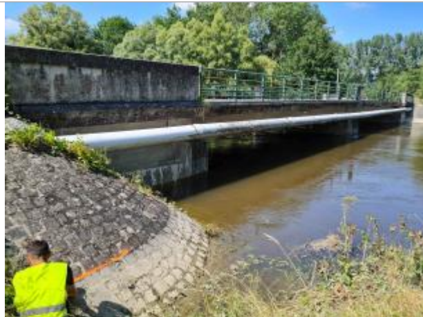
Talus sous le Pont de la RD 37
