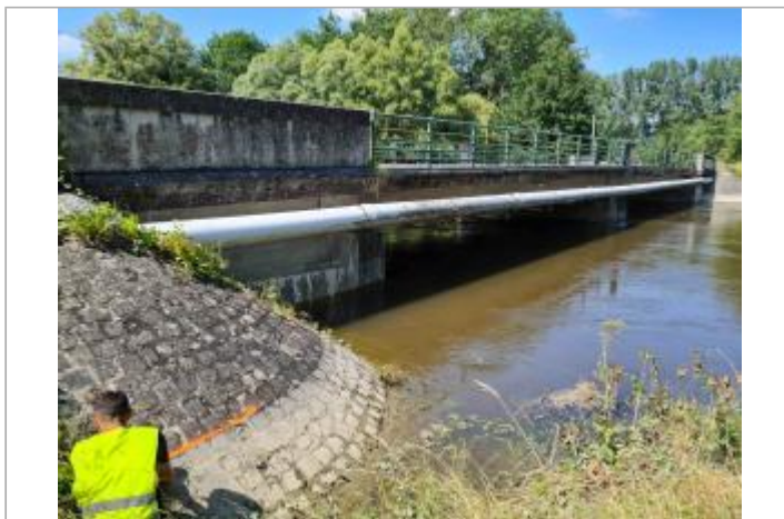
Talus sous le Pont de la RD 37
