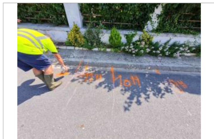
Marque de peinture, horodaté. (reporté sur les tubes de la cloture du n°3 de la rue à 26 cm/pile)
