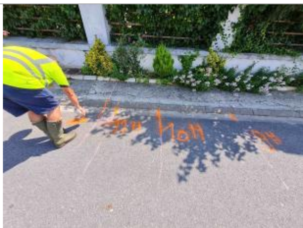
Marque de peinture, horodaté. (reporté sur les tubes de la cloture du n°3 de la rue à 26 cm/pile)
