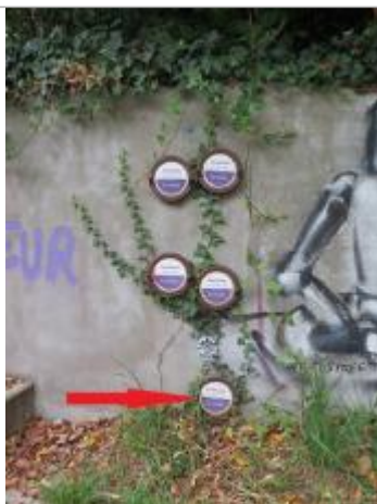
Repère normalisé de l'inondation du 21 février 1977
