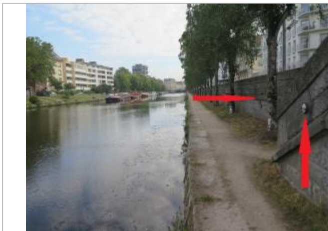
Quai de la Prévalaye escalier face à la rue des Trente
