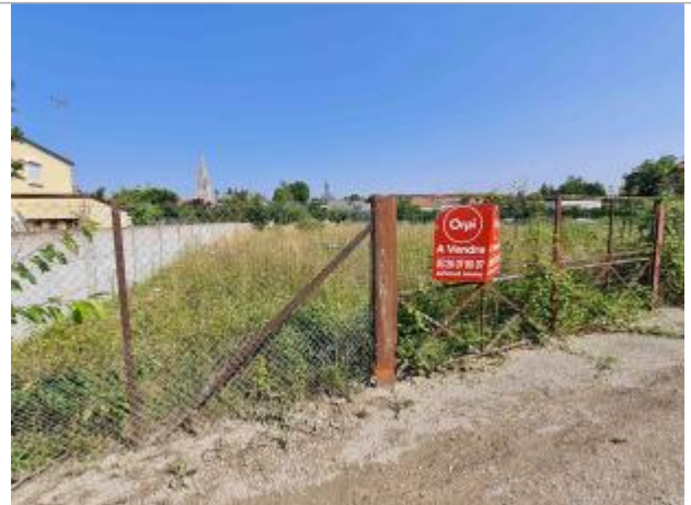
Portail en fer rouillé, rue de l'Ancienne Place après le n°3.
