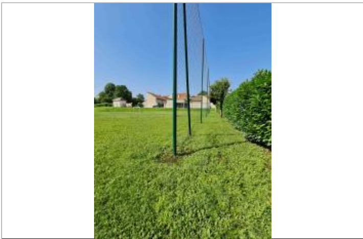
Poteau vert (support de filet de protection) situé derrière le but situé au Nord du terrain proche de la rue de l'Ancienne Place.
