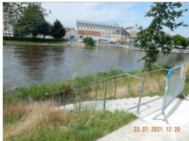
Escalier en ciment rive droite sur voie piétonne, 300 m en aval du Pont Gambetta
