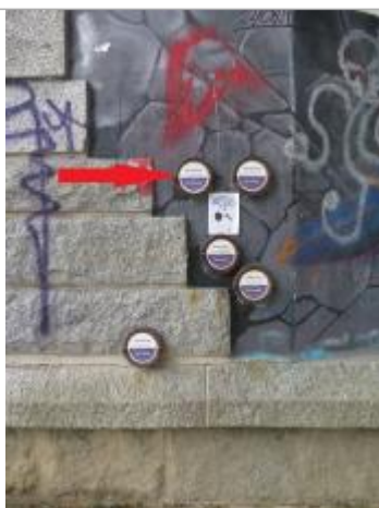
Repère normalisé de l'inondation du 26 octobre 1966
