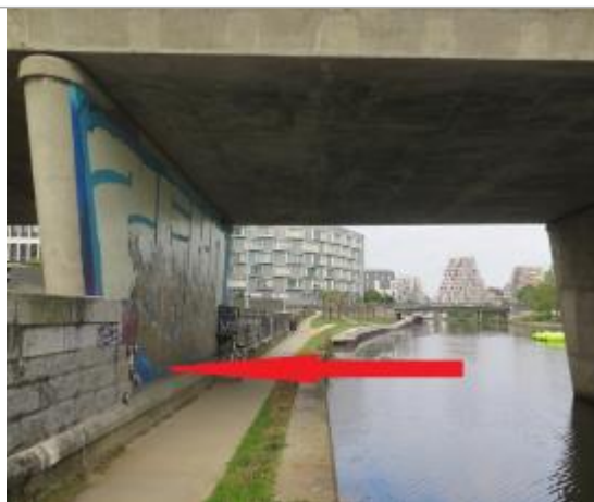
Muret de protection sous le pont Malakoff rive gauche
