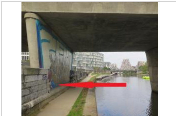
Muret de protection sous le pont Malakoff rive gauche
