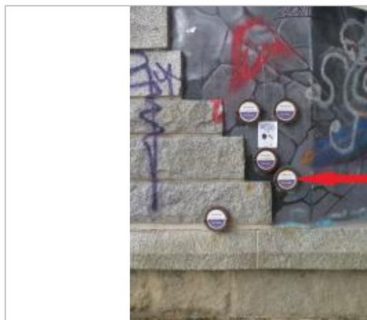
Repère normalisé de l'inondation du 21 janvier 1995
