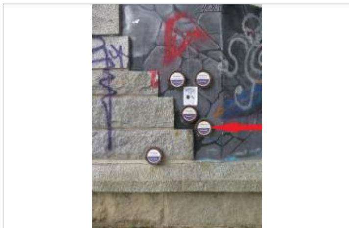
Repère normalisé de l'inondation du 21 janvier 1995
