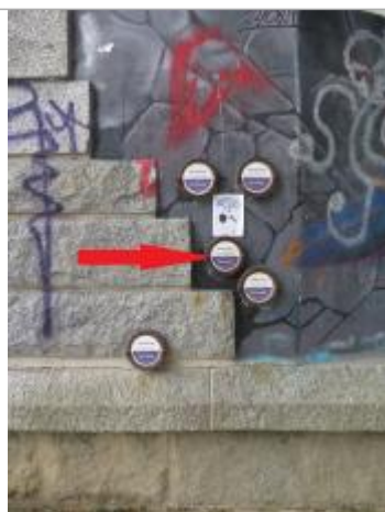
Repère normalisé de l'inondation du 29 décembre 1999
