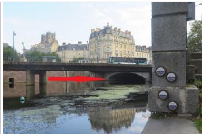
Repères de crues quai de la Prévalaye et pont de la Mission
