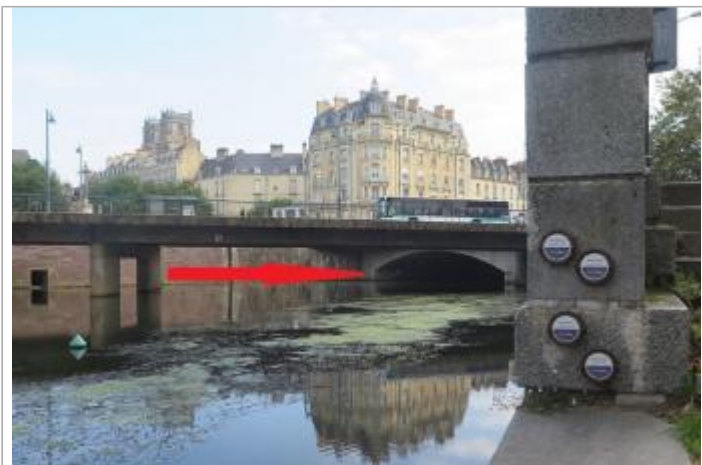
Repères de crues quai de la Préalaye et pont de la Mission
