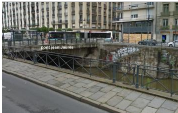
Pont Jean Jaurès (escaliers)
