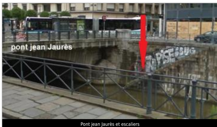
Pont Jean Jaurès et escaliers
