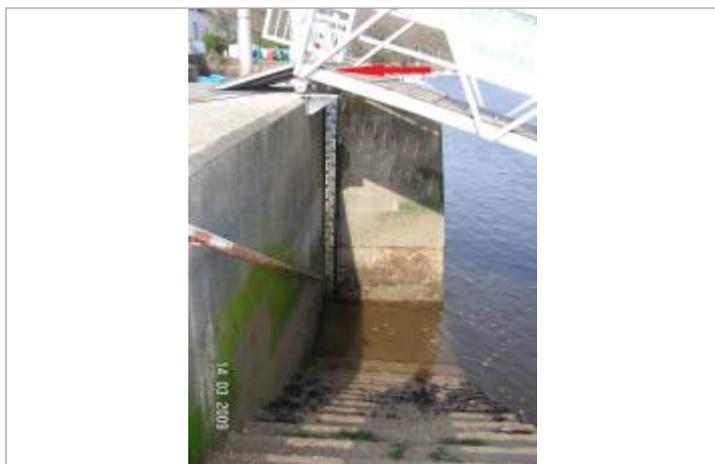
Echelle limnimétrique sous le ponton du port
