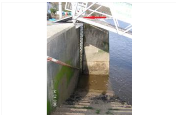
Echelle limnimétrique sous le ponton du port
