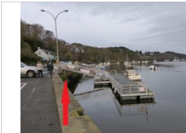
Station marégraphique du port de plaisance du Pouldu à Clohars-Carnoët
