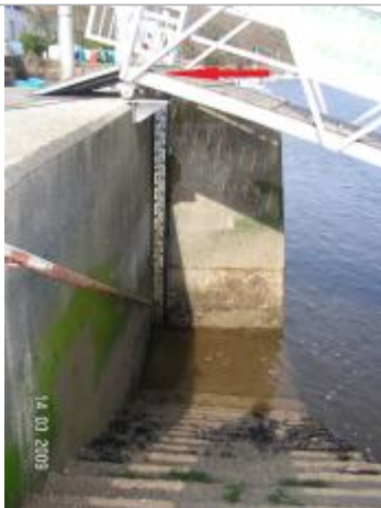
Echelle limnimétrique sous le ponton du port
