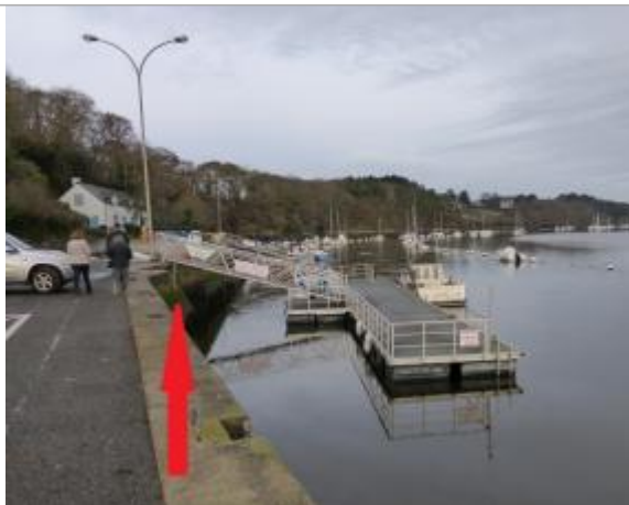
Station marégraphique du port de plaisance du Pouldu à Clohars-Carnoët
