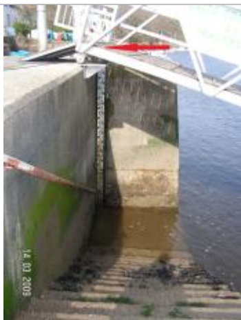
Echelle limnimétrique sous le ponton du port
