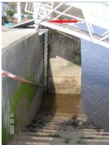
Echelle limnimétrique sous le ponton du port
