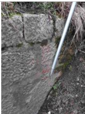
Marque sur le pont, amont RD
