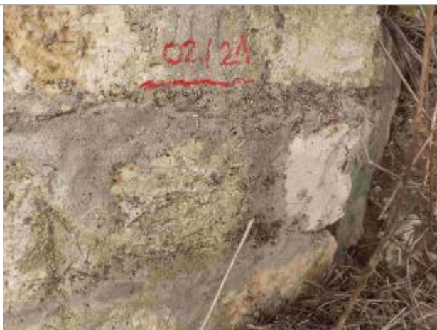
Marque sur le pont, amont RD
