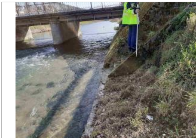
Côté de l'escalier, à l'aval du pont RG
