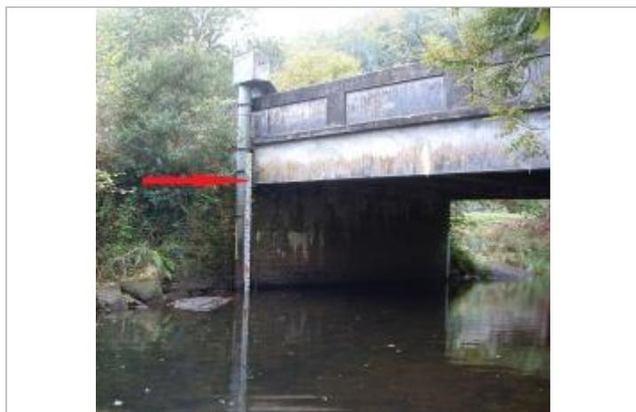
Echelle limnimétrique en aval du pont rive droite
