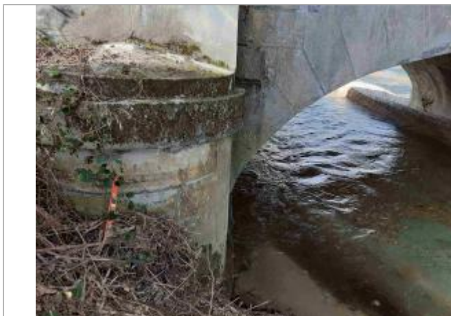
Amont du pont, rive gauche
