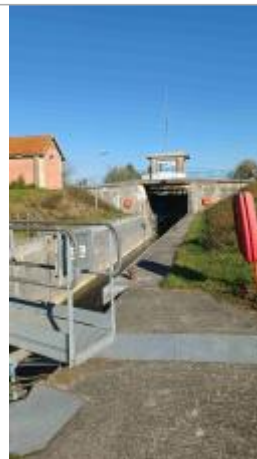
Echelle limnimétrique sur mur de l'écluse, rue des Ecluses.
