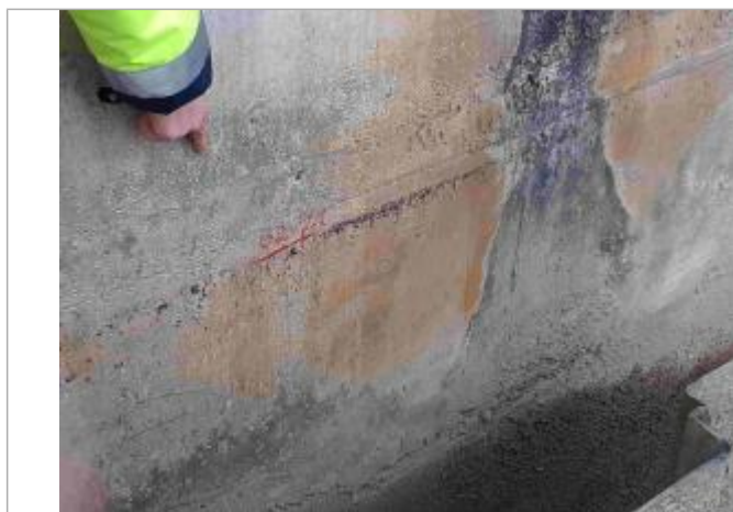
Marque faite sur le pont, amont rive gauche
