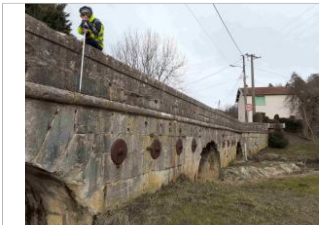
Ouvrage de décharge, 3ème arche depuis la rive droite
