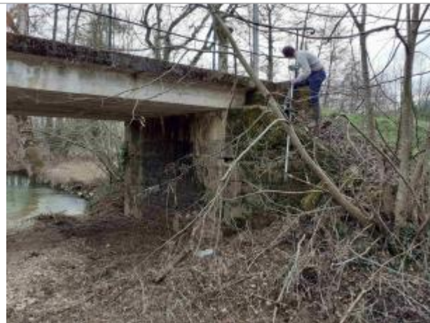
Aval du pont, rive gauche
