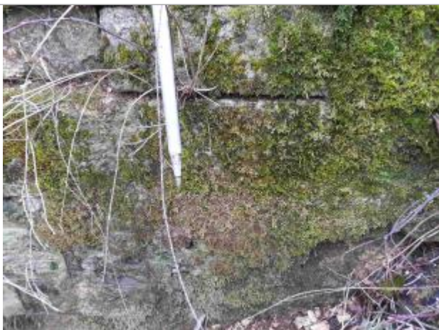
Marque à l'aval du pont en rive gauche
