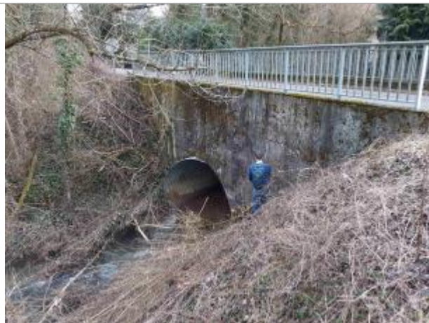
Buse à l'aval du pont
