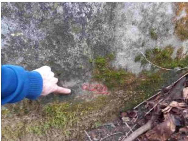
Marque au niveau du mur à côté de la buse du 2nd bras, à l'aval rive gauche
