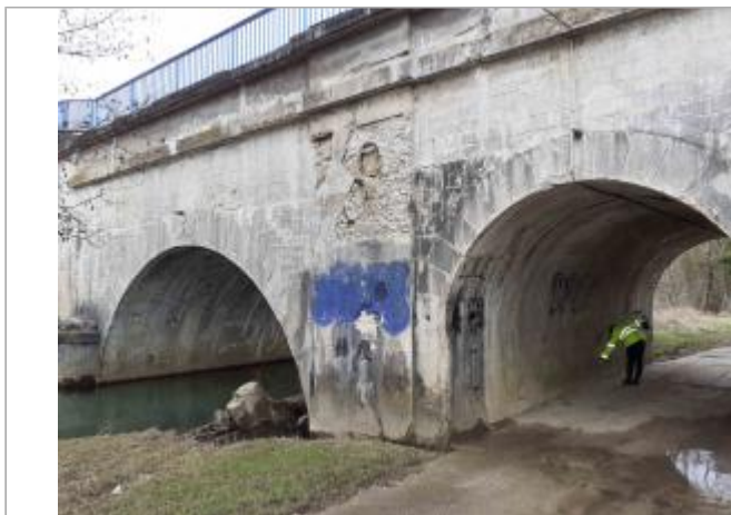
4ème arche sous le pont canal
