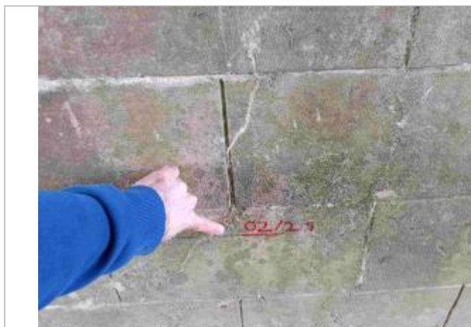
Marque sur la 4ème arche, rive droite, sous le pont canal
