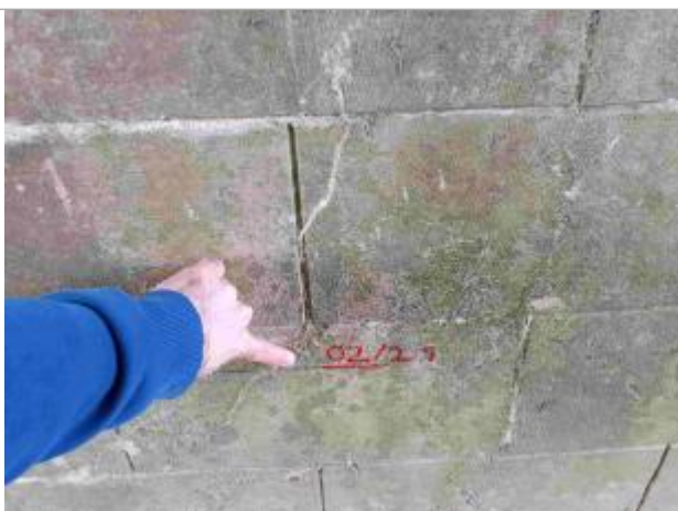
Marque sur la 4ème arche, rive droite, sous le pont canal
