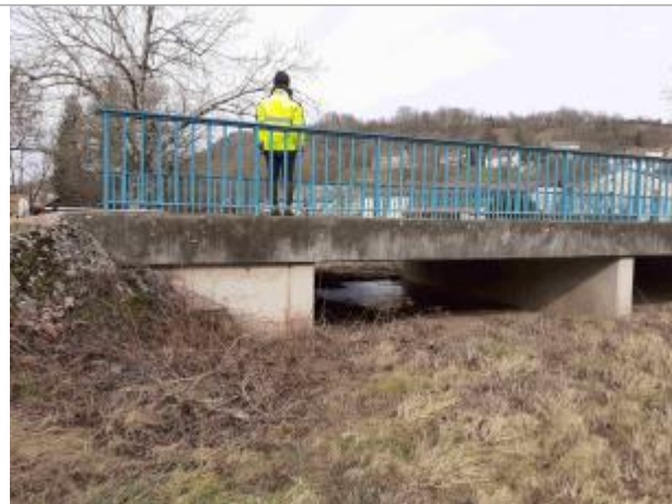
Amont du pont de décharge, sur la D5
