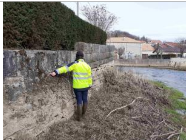
Amont du pont de la D5 sur l'Ornain
