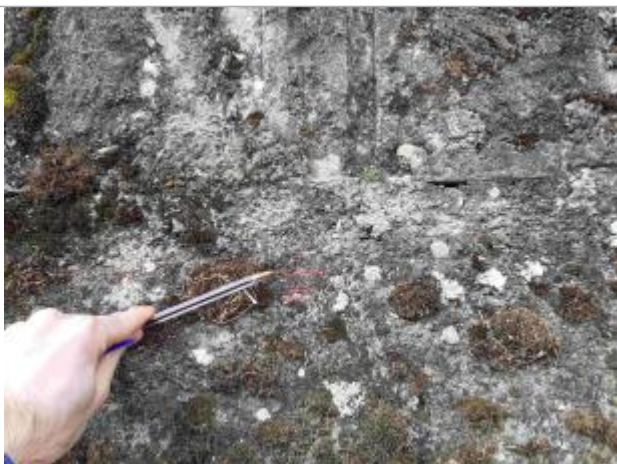
Marque à l'amont du pont, en rive gauche
