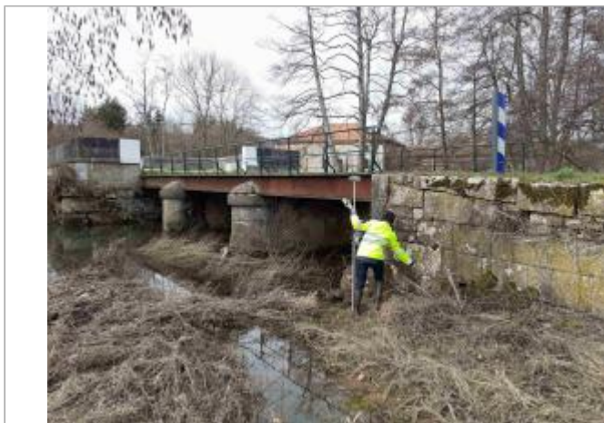
En amont du pont sur l' Orvain
