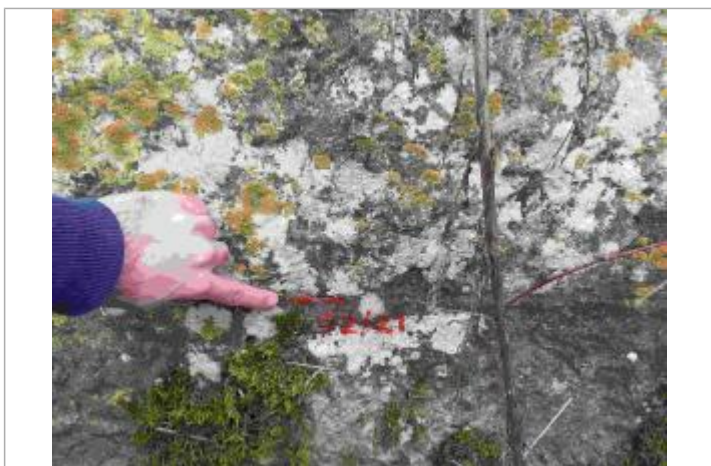
Marque en amont rive droite sur le pont
