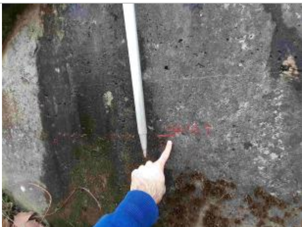
Marque sous le pont, aval rive droite
