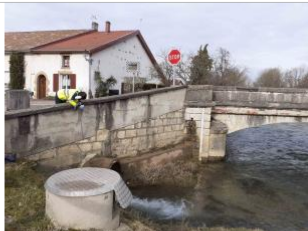
Amont du pont, rue de l'Ornain
