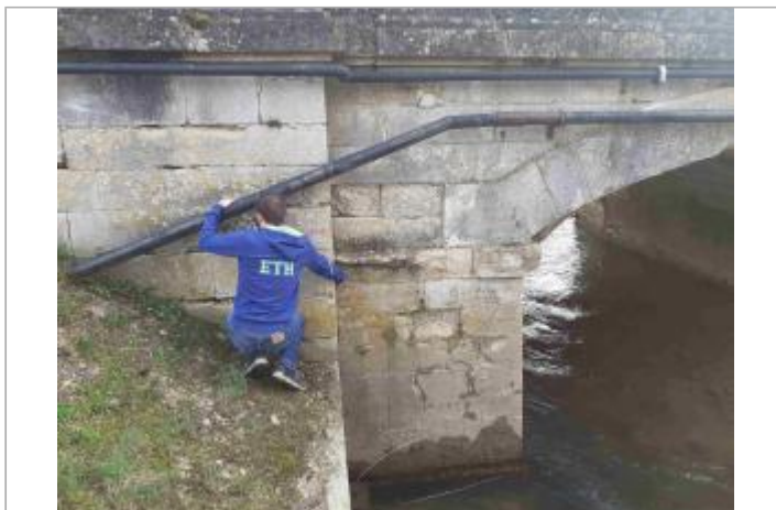
Aval du pont sur la RD120A
