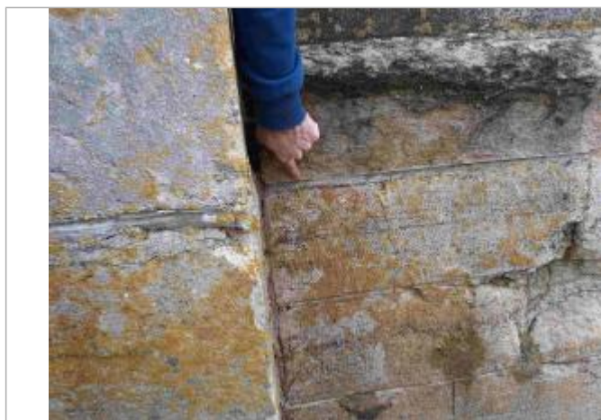
Marque sous le pont, rive droite
