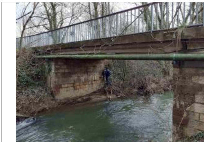
Pont rue de la gare
