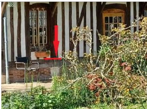
Laisse de crue en haut de la poutre au dessus du mur de brique sur la façade EST, à 65 cm/sol.
