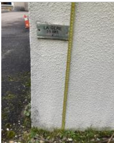
plaque posée sur le mur du bâtiment
