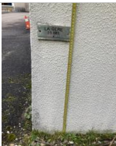
plaque posée sur le mur du bâtiment
