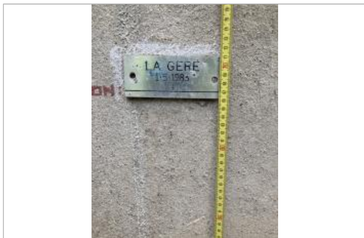
plaque posée sur le mur du bâtiment
