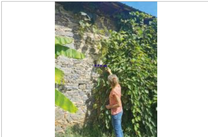
Mur de la dépendance
