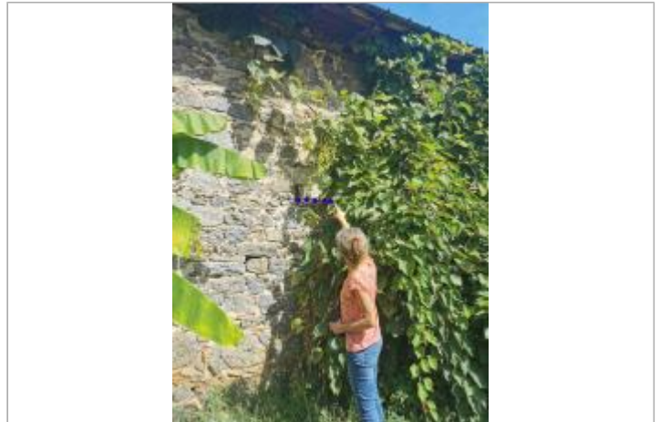
Mur de la dépendance
