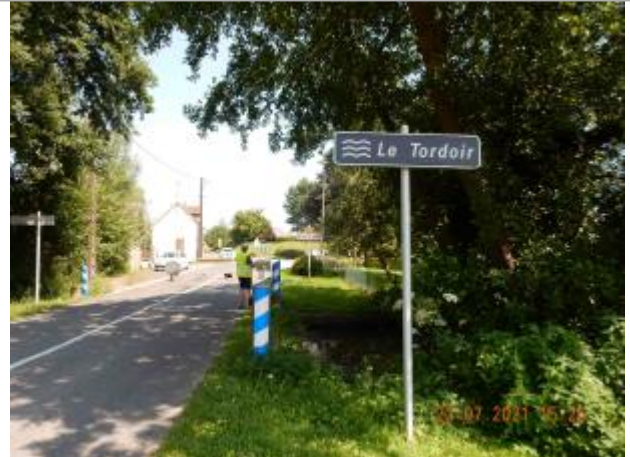
Pont en ciment sur le ruisseau "Le Tordoir", sur la RD 925 à la sortie de Beaurieux.
