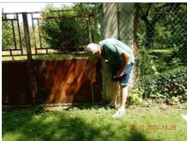
laisse de débris de végétaux sur portail à 21.5 cm/sol
