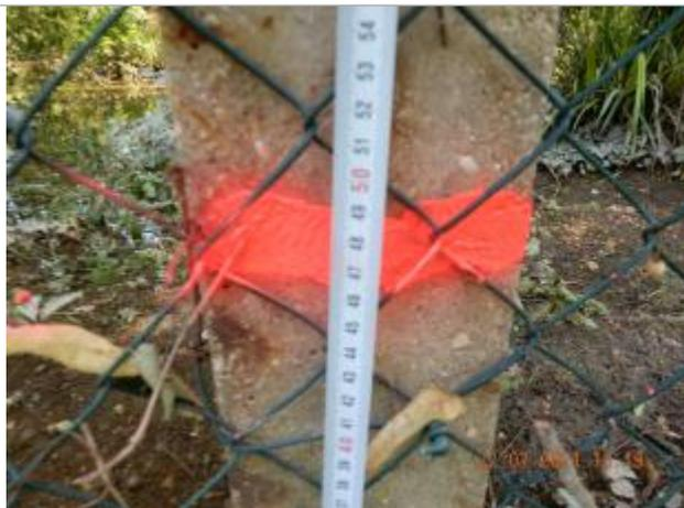
Laisse de crue sur poteau en ciment de la cloture grillagée à 46 cm/sol
